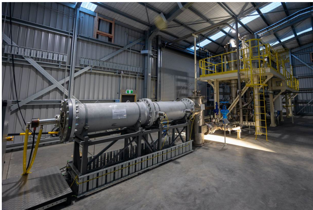
Image 1 : Système de destruction de réfrigérants dangereux par arc plasma à vapeur (SPARC TM ) de PyroGenèse, présenté lors de l'inauguration de l'installation nationale de destruction des réfrigérants de la Nouvelle-Zélande. Crédit photo : Jamie Troughton/Dscribe Media.
